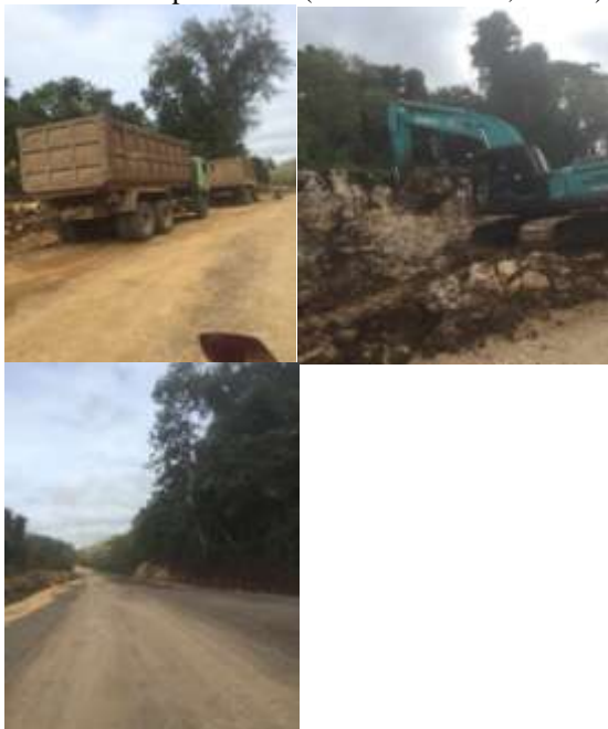
Gambar 2. Proses Pembangunan Jalur Lintas Selatan
