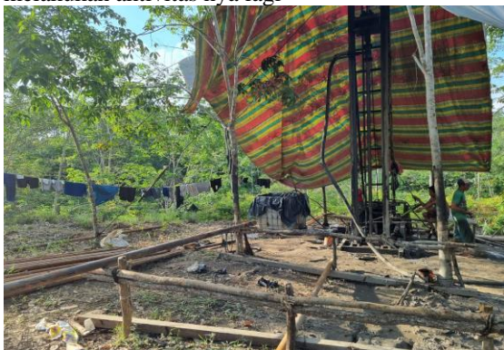
Gambar 2 Lokasi Penambangan Minyak Ilegal Desa Keban 1
