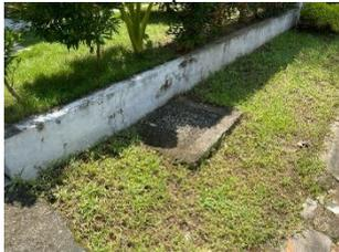
Gambar 3 Saluran Pembuangan Air Limbah Rumah
