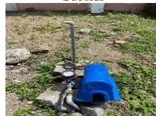
Gambar 8 Kotak Meteran Air PT. Air Minum Giri
